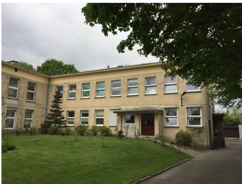
Elewacja wschodnia – skrzydło zachodnie – przedsionek wejściowy
