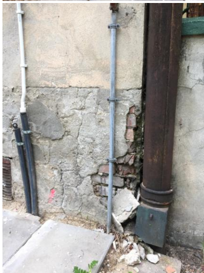
Ubytki w ścianach piwnic
