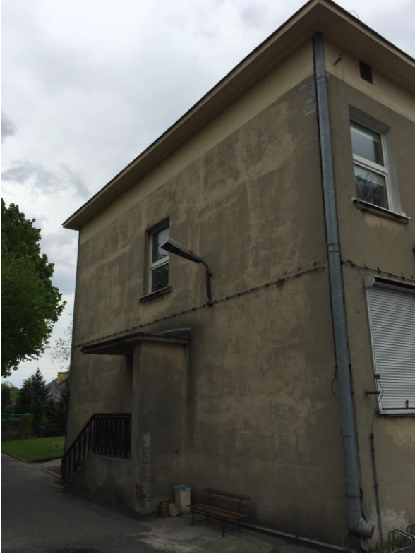
Elewacja północna skrzydło zachodnie- schody wejściowe
